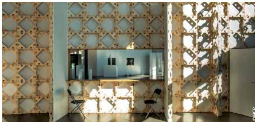
*Ecoconception. MCB Atelier (Lauréat BeCircular 2016) a créé une structure flexible et réutilisable à partir de modules en bois belge de 50 x 50cm : les MOD's. Ces modules peuvent servir à monter et démonter facilement des structures variées (décors, stands, murs d'expositions, etc.). Le démontage permet aux matériaux consacrés à la structure d'être récupérés et éventuellement réutilisés.*
